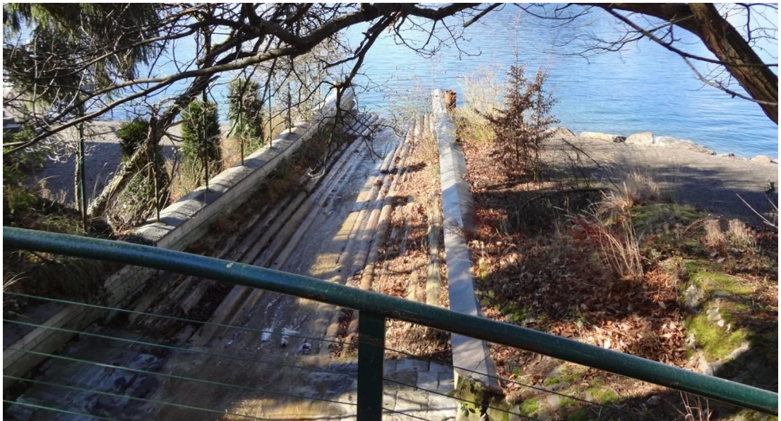
Abbildung 16: Die Einmündung des Altdorfbachs in den Vierwaldstättersee ist mit einer Holzrampe gesichert. Foto: Heini Geomatik AG [22].
