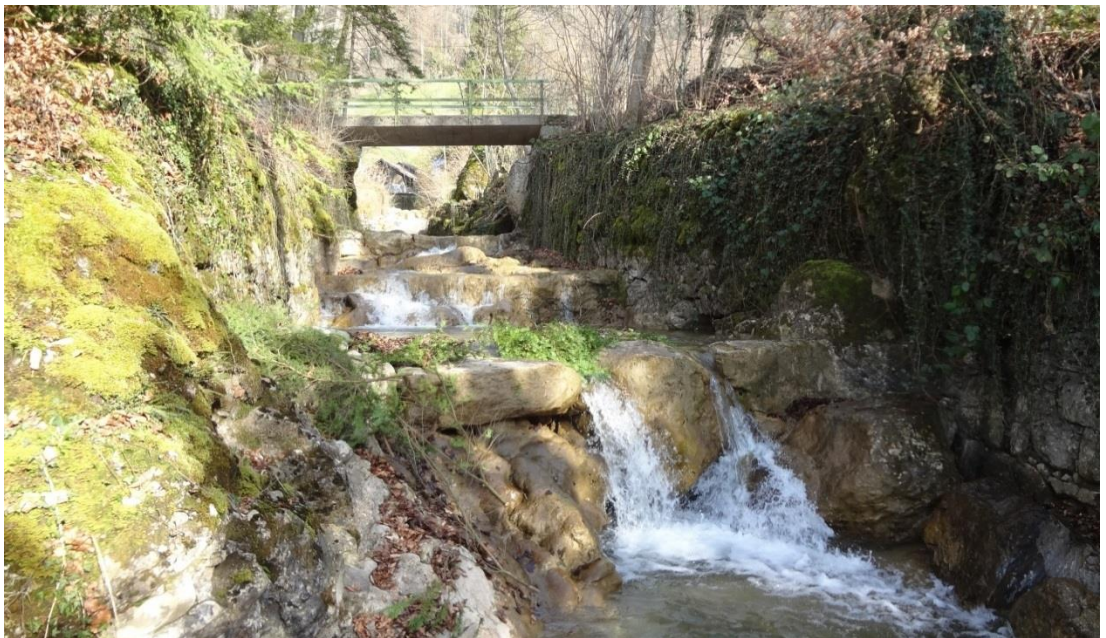
Abbildung 14: Gerinne unterhalb der Brücke zwischen Bachtale und Büntli bei 0+360 mit Bachsohlenschwellen aus Blöcken und Mauern an den Bachböschungen. Foto: Heini Geomatik AG [22].
