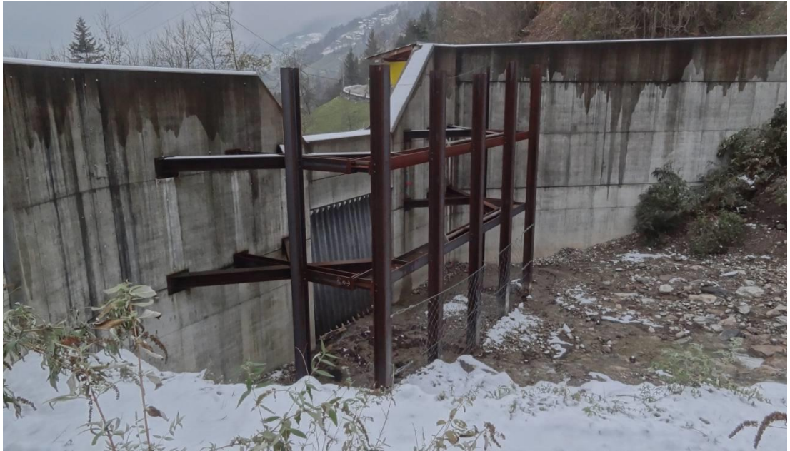
Abbildung 13: Geschieberückhaltebecken am Kegelhalz des Altdorfbachs, realisiert 2006, mit vorgeschalteter Stahlkonstruktion mit Maschendrahtnetz als Holzfang sowie einer Grundöffnung mit Stahlrechen.
